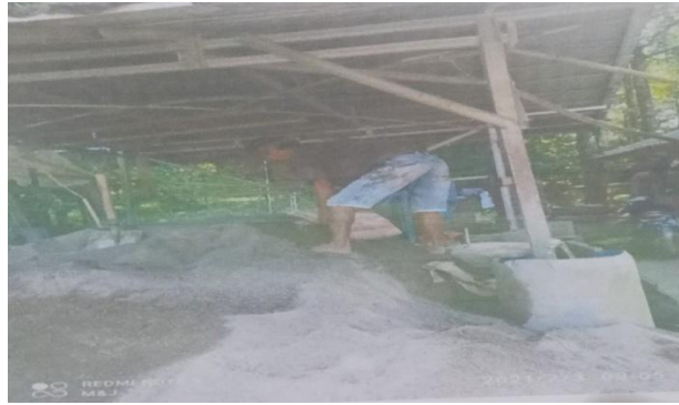
Gambar 4: pekerja sedang melakukan pencampuran material pembuatan paving
