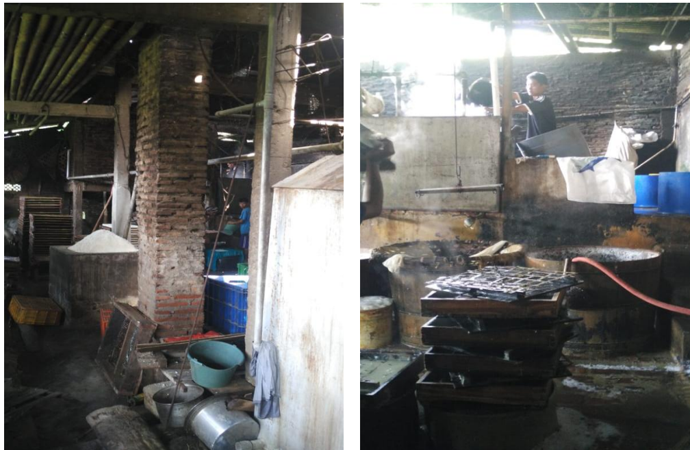
Gambar kondisi Bangunan Tahu
