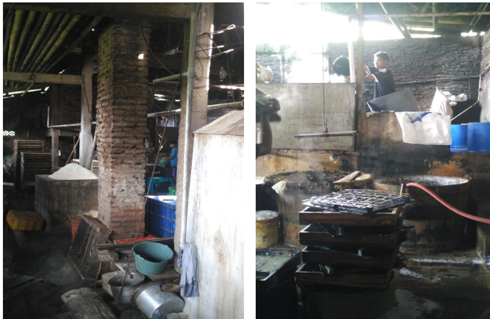
Gambar kondisi Bangunan Tahu
