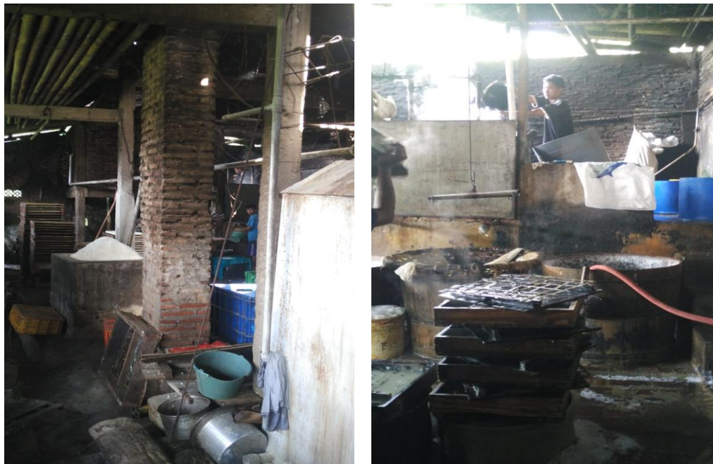
Gambar kondisi Bangunan Tahu
